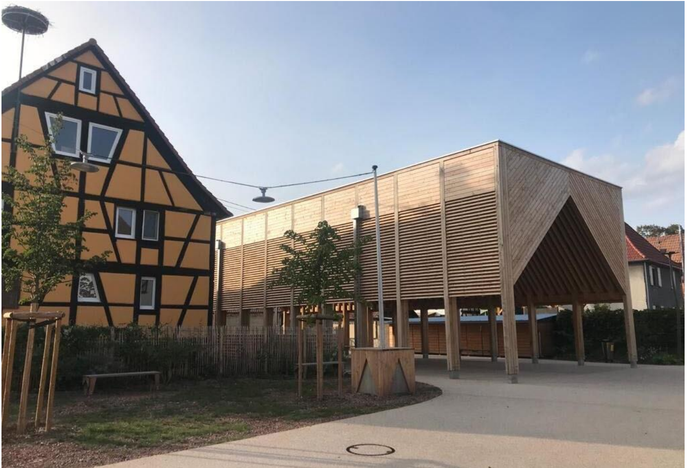
Die „Halle der Synergien“, ein neuer Treffpunkt im Herzen von Muttersholtz | Foto: AFR
